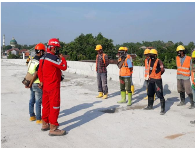
OBSERVASI SECARA LANGSUNG TERKAIT DENGAN ALAT PELINDUNG DIRI LENGKAP PARA PEKERJA
